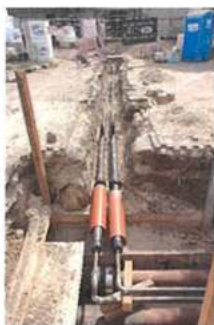
Távhővezeték fektetés, nyomvonal fektetése
