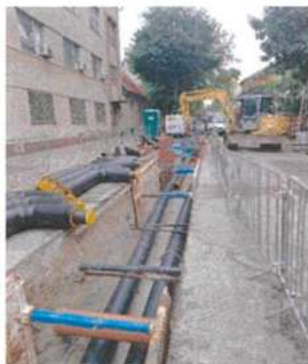
Távhővezeték fektetés, munkaárok dúcolással
