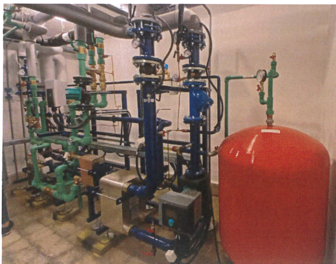
19. ábra: Modul rendszerű hőközpont
