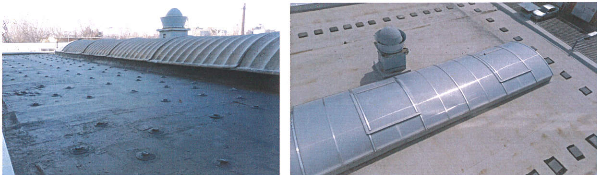
30. ábra: Csarnok tető felújítás előtt és után
