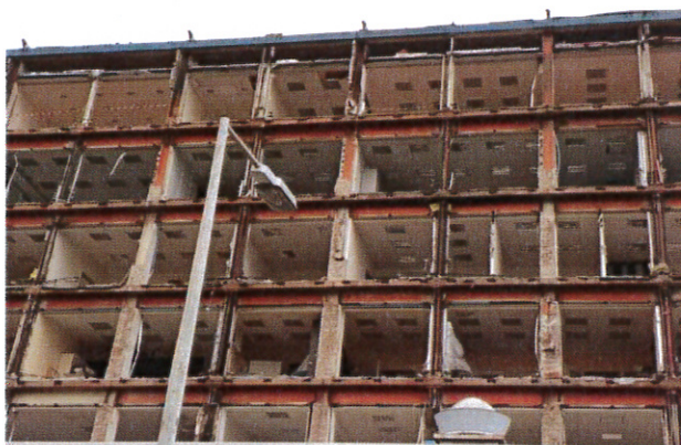
24. ábra: A „B” épület az azbesztmentesítés után, és az új homlokzat
