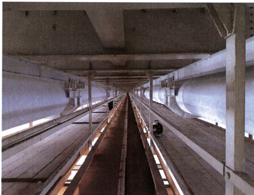
18. ábra: Erzsébet-hídon átvezetett távhővezeték
