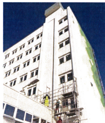
24. ábra: A „B” épület az azbesztmentesítés után, és az új homlokzat
