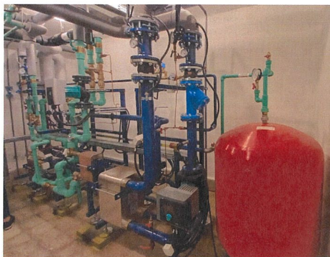
17. ábra: Modul rendszerű hőközpont
