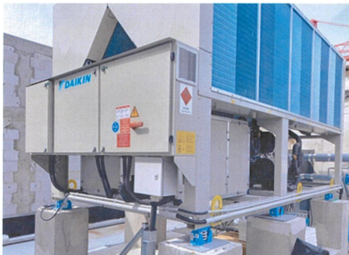
24. ábra: Budapest BRF épület hőszivattyú telepítése
