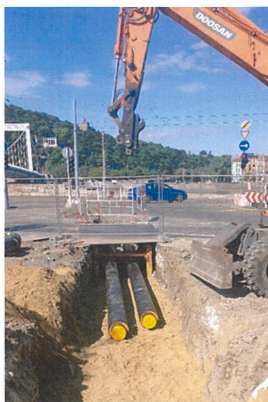
20. ábra: Épülő távvezeték
