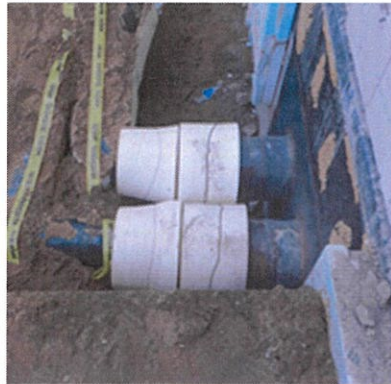
22. ábra: BudaPart BRF épület csatlakozási pontjának kivitelezése
