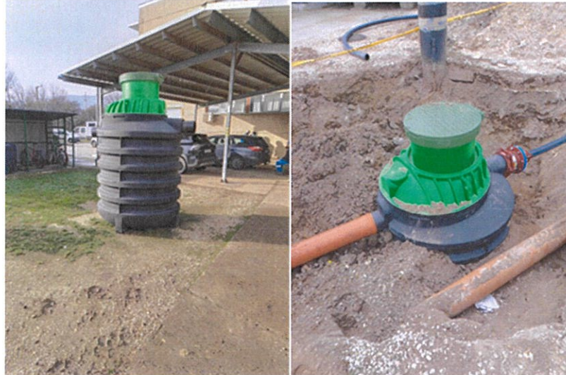
25. ábra: Olajleválasztó berendezés a beépítés előtt és után
